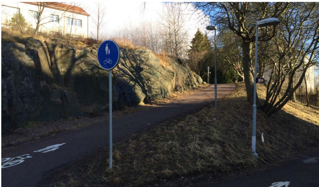
Foto 3. Bergsslänten i NO utmed gång- och cykelbanan.
